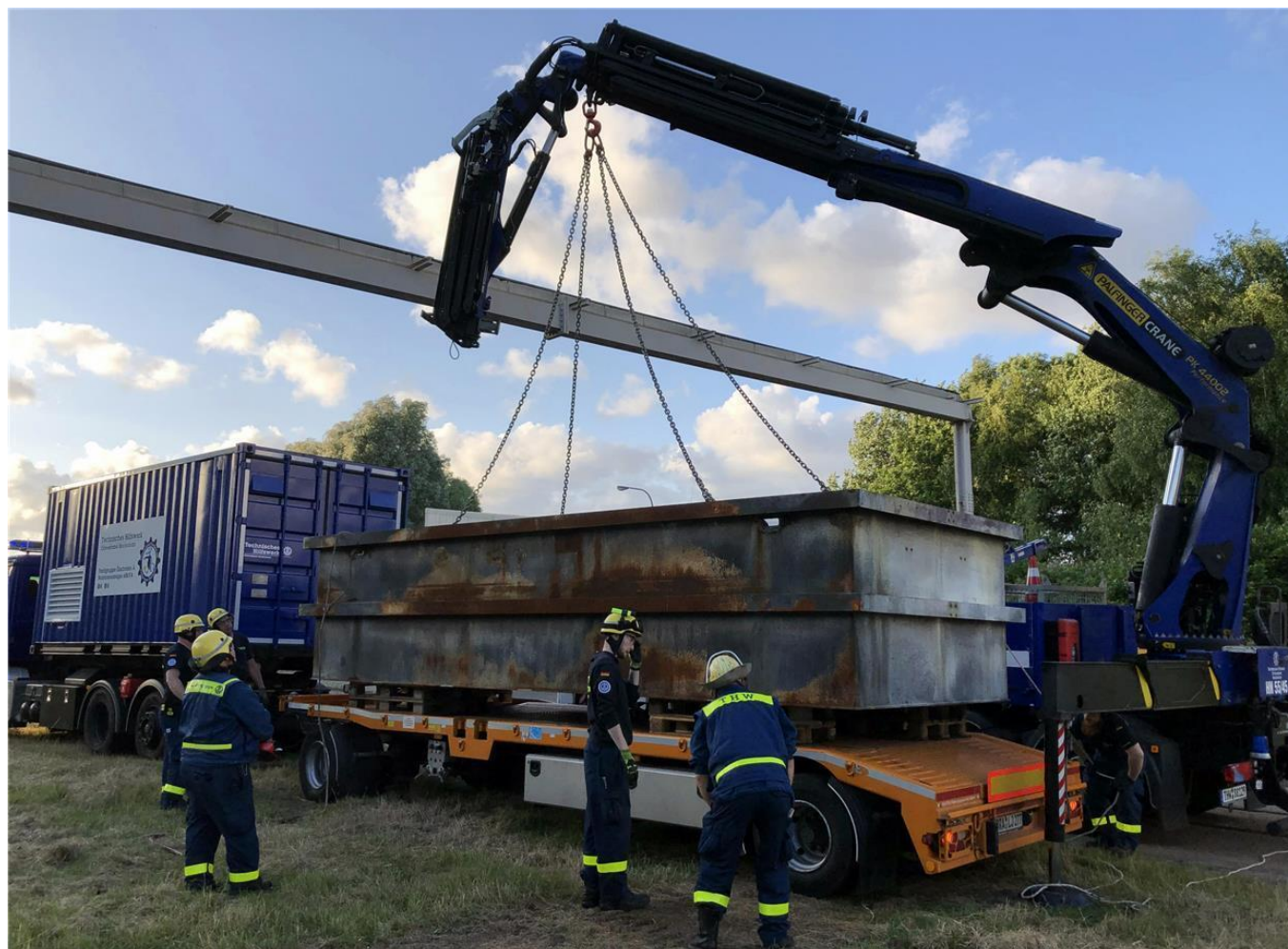
Der Transport des fünf Tonnen schweren, 6, 6 Meter langen und 2,6 Meter breiten Mofitrogs hat reibungslos geklappt. Foto: Flor
