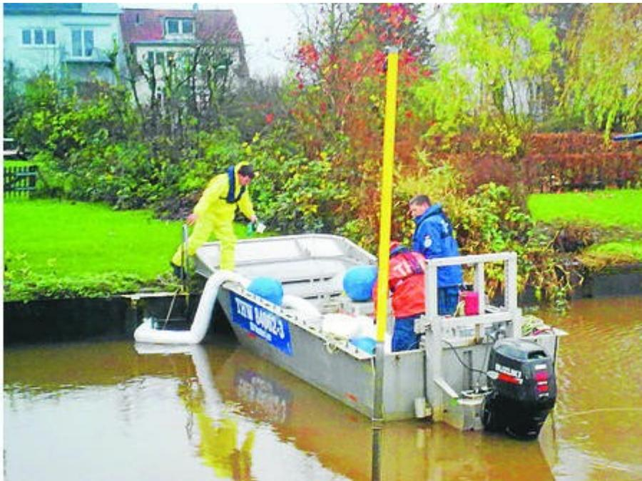
Bild: THW Die Helfer vom THW Nordenham legten den ganzen Tag Ölsperren auf der Hunte vor Elsfleth.
