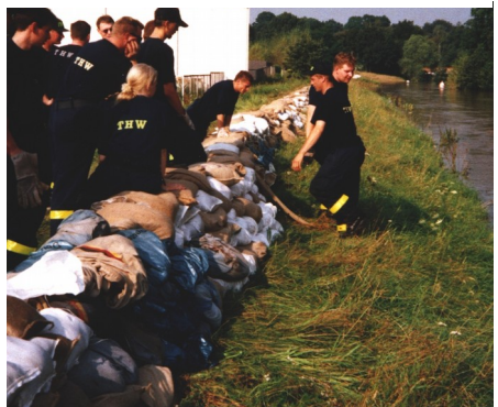
Erhöhung eines Deiches (Dessau, Elbeflut 2002)
