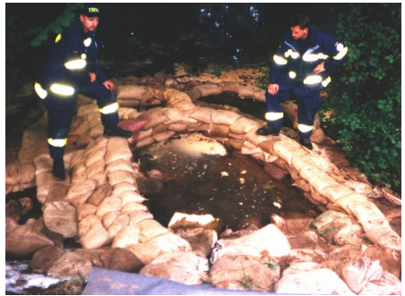
Bau einer Quellkade mit Wasserschlössern (Aken, Elbeflut 2002)
