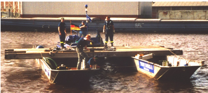
Schwimmende Arbeitsplattform (Binnenhafen Brake)
